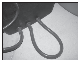
Sorties non utilisées branchées à la tuyauterie
