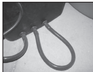
Sorties non utilisées branchées à la tuyauterie
