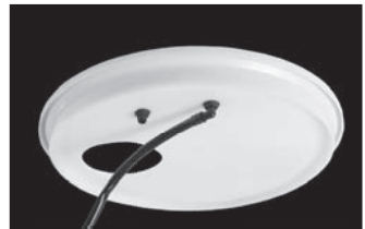
Arandelas instaladas en la tapa del depósito
