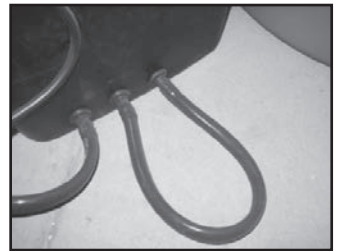
Nicht benutzte Auslauföffnungen, die mit Schläuchen untereinander verbunden sind
